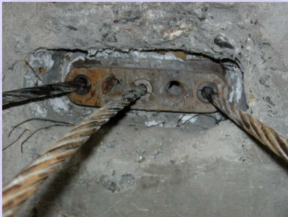
(d) Anchorage block at stretching end
